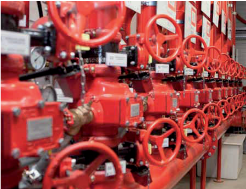
Voor de aanleg van de sprinklerinstallatie is ongeveer tachtig kilometer leidingwerk geplaatst.
